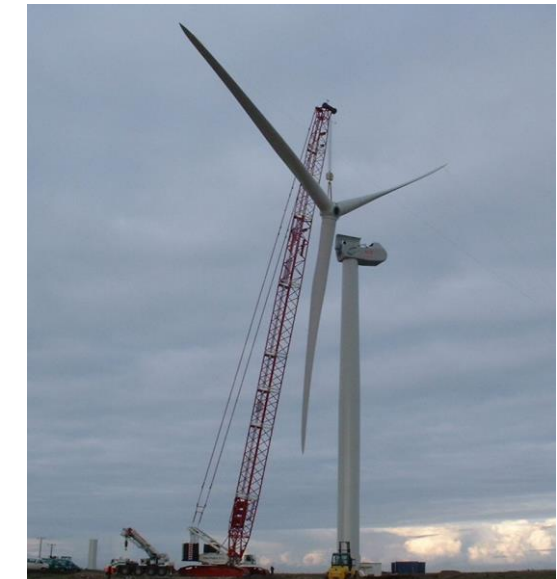
Montage du rotor
