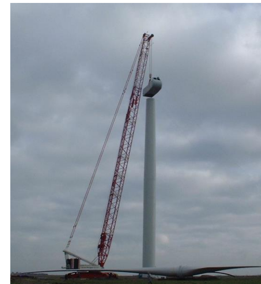
Montage de la nacelle
